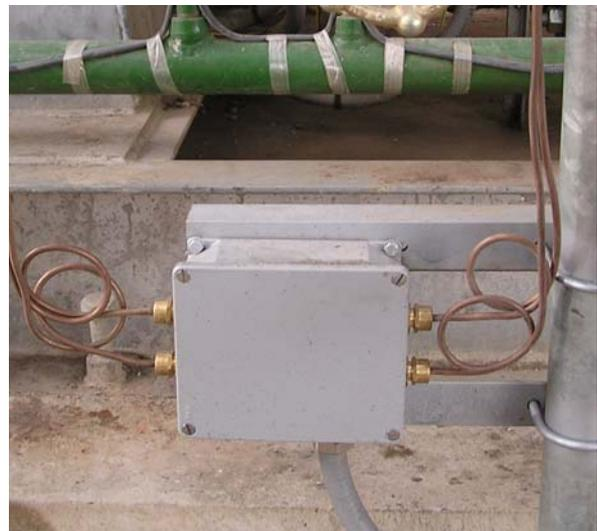
Il fissaggio del cavo scaldante sulla tubazione sarà fatto con delle fascette in acciaio inox per linee di diametro fino a 6".
