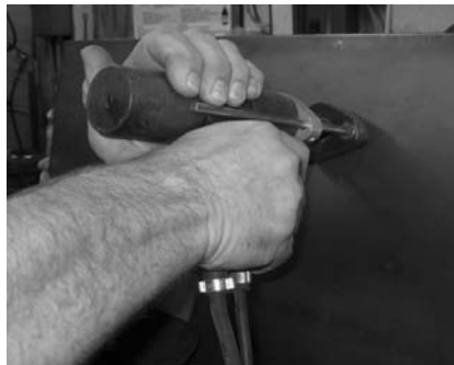
b.) Weld Stud to Hopper Wall
