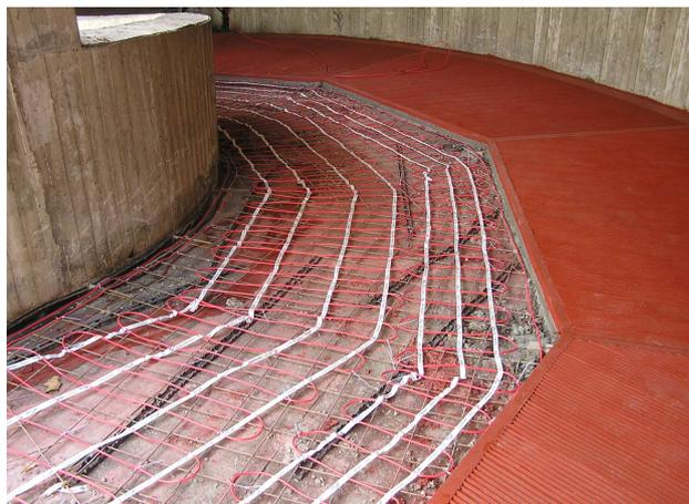
**I CIRCUITI POSSONO ESSERE FORNITI SINGOLARMENTE E STESI DIRETTAMENTE SULLA RETE ELETTRICALDATA**
