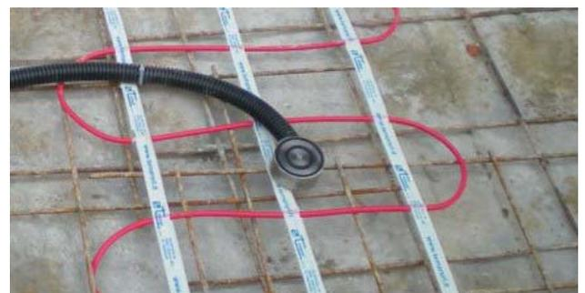
Il sensore deve essere installato nel punto più freddo e ombroso della rampa, tra due spire di cavo scaldante.
